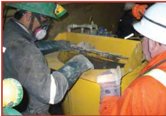
Pan American Silver, Proyecto Huaron, Perú Se utilizaron lechadas de cemento para reducir infiltraciones de agua de alto volumen en condiciones de suelo fracturado y saturado de agua antes de la construcción del pozo, utilizando métodos convencionales de profundización.
