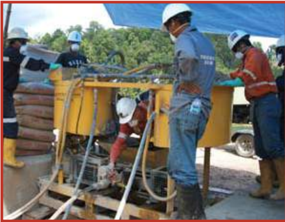
Minería Newcrest, Proyecto Kencana K2, Indonesia Se utilizaron lechadas de cemento microfino para mejorar las condiciones del suelo en condiciones de suelo fracturado y saturado de agua antes de la construcción del pozo de ventilación, utilizando métodos de perforación en remonta.
