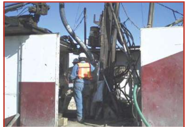
Recursos Excellon, Mina Platosa, México Se realizaron operaciones de perforación profunda y de inyección de cemento de alto volumen para sellar formaciones rocosas saturadas de agua y recuperar con éxito una mina de plata inundada.
